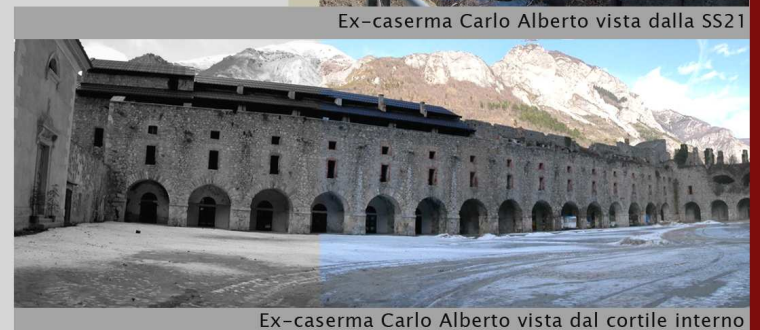
Ex-caserma Carlo Alberto vista dal cortile interno
