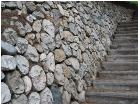
Contenimento delle scarpate con pietra locale a secco
