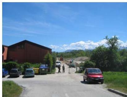
2. Accesso all'area del nuovo parcheggio
