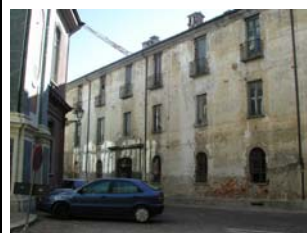
Il degrado di Palazzo Samone
