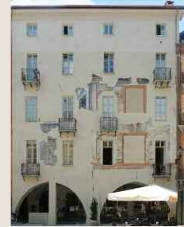
FACCIATA DOPO IL RESTAURO
