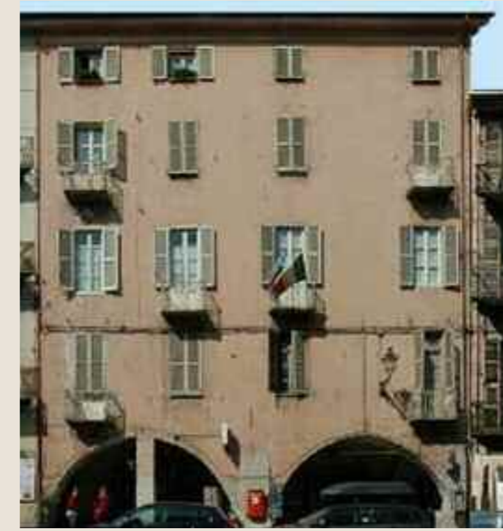
FACCIATA PRIMA DEL RESTAURO
