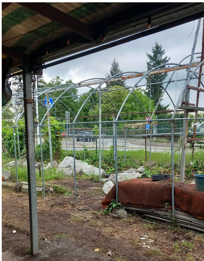
archi di supporto a tunnel
