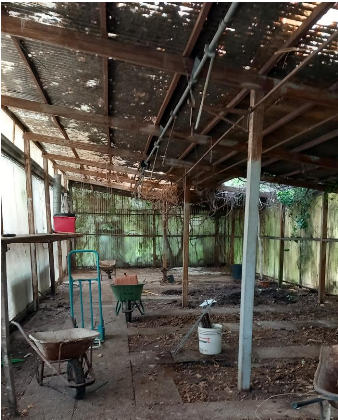
struttura in ferro
