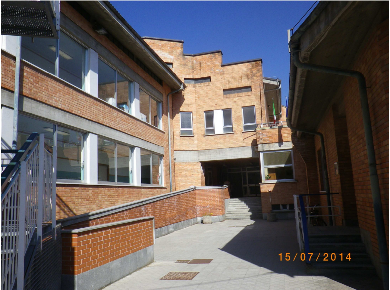
Vista edificio dall'ingresso con serramenti esterni – lato V.le Angeli
