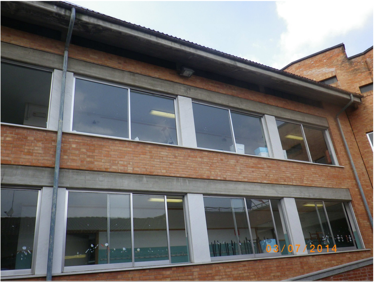
Grande incidenza delle superfici vetrate sul totale dei tamponamenti esterni dell'edificio
