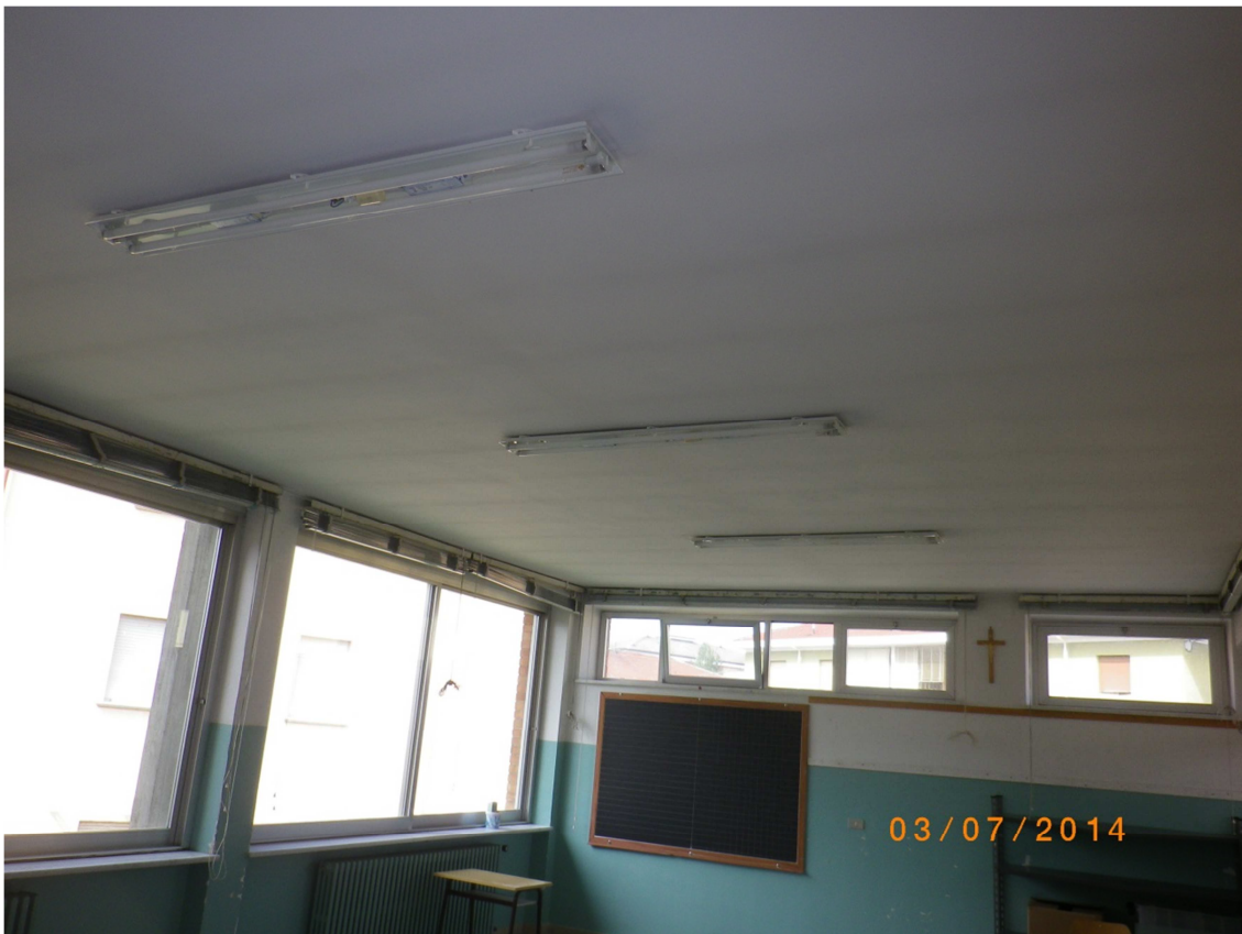
Vista serramenti esistenti in aula angolare
