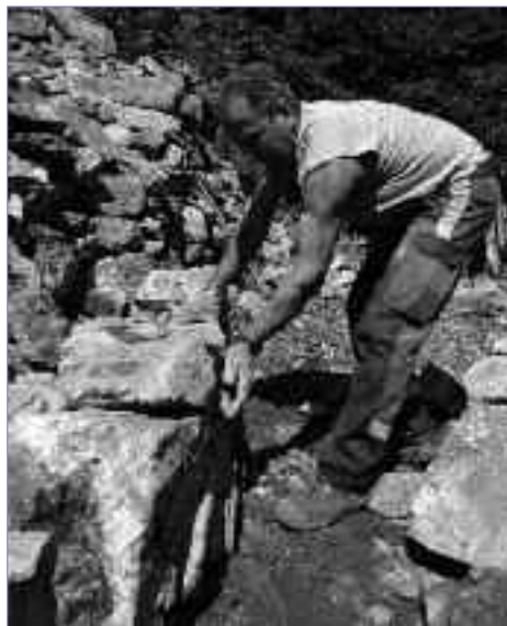
Giovanni Dalmasso costruisce un muro di contenimento in pietra a secco lungo il sentiero del Vallone della Vagliotta
