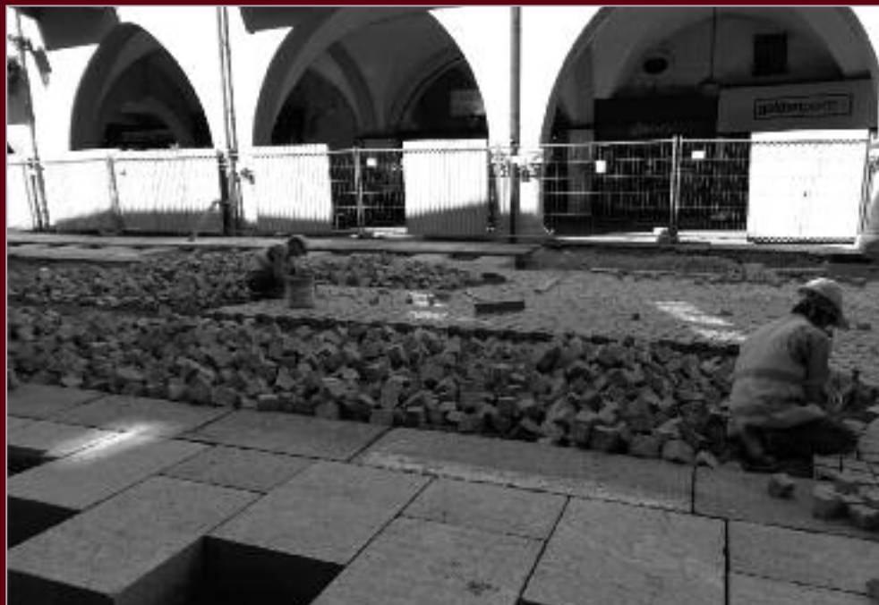
Cantieri in via Roma (Foto di Teresa Maineri)
