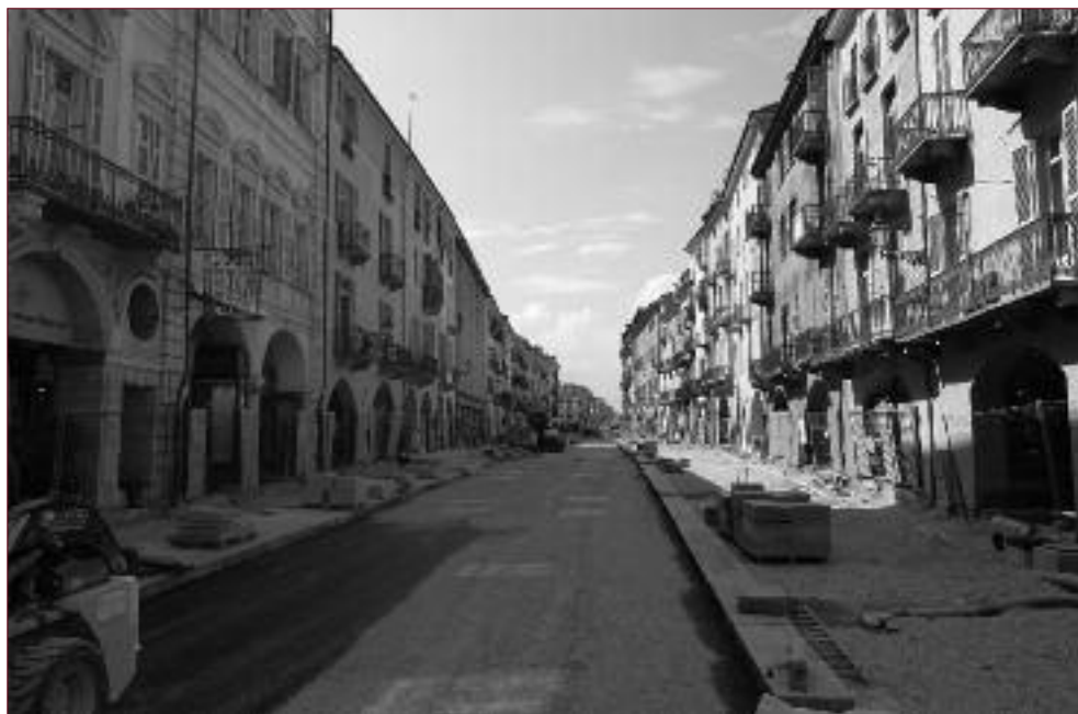
Cantiere in via Roma
