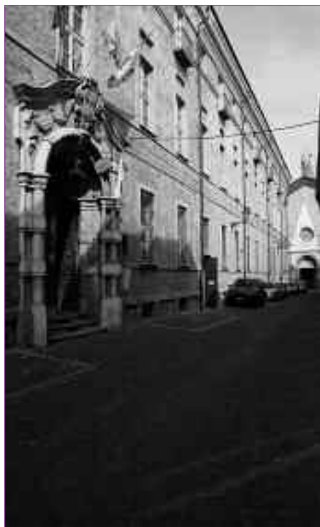
La parte dell'ex Ospedale che si affaccia su via Santa Croce, oggetto del primo lotto di interventi
