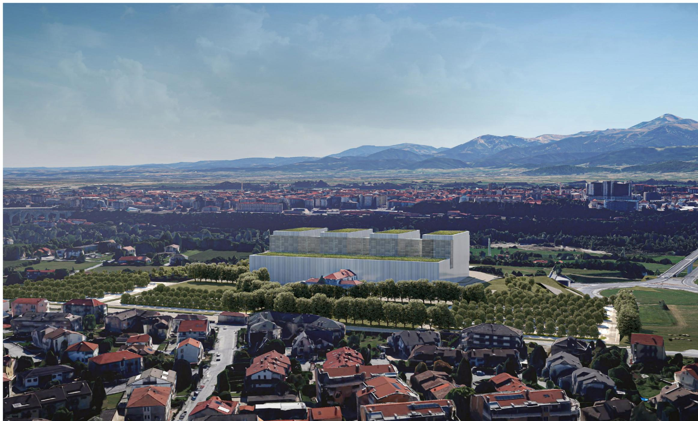
L'ospedale unico a tipologia verticale è definito dalla sovrapposizione di una piastra di 5 livelli e moduli degenza, anch'essi su 5 livelli con un piano tecnico soprastante. Vista tale conformazione, al fine di limitare lo sviluppo in altezza e quindi l'impatto sul contesto, si prevede di interrare due piani di piastra, a differenza della tipologia orizzontale dove vi è un solo piano interrato.
