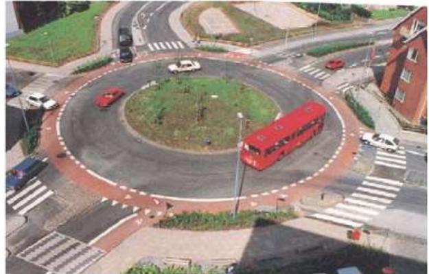
La documentazione fotografica allegata riporta il paradigma di Grosseto (rotonda tra via della Repubblica e via Einaudi) dove la ciclabile in rotonda (con anello interno) è protetta da apposita cordonatura, il conducente del veicolo in approccio alla rotonda viene allertato da attraversamenti pedonali rialzati.
