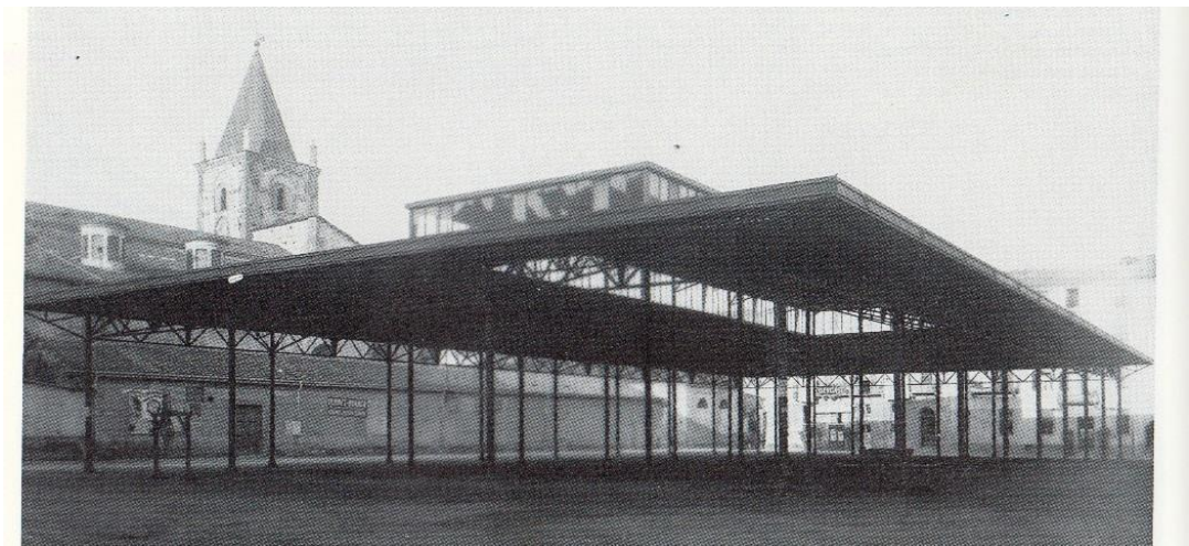
La tettoia metallica del 1934
