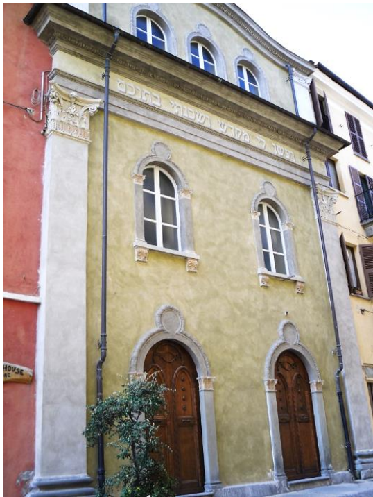
Foto 1 - La facciata della Sinagoga, in Contrada Mondovì n. 20
