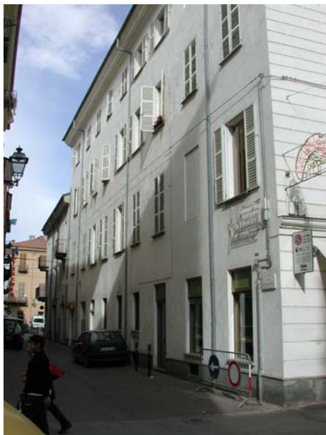
Foto 3: vista stato attuale dalla via Savigliano
