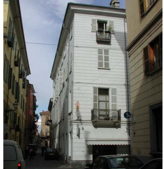
Foto 2: vista stato attuale dalla via Savigliano
