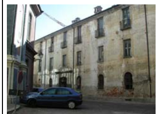
Il degrado di Palazzo Samone
