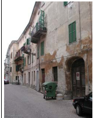
Edifici residenziali degradati compresi nell'area del programma di Contratti di Quartiere II
