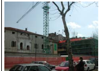
Il cantiere dell'ex Mater Amabilis
