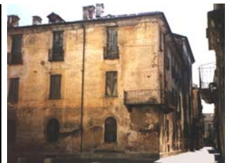
Il degrado di Palazzo Samone
