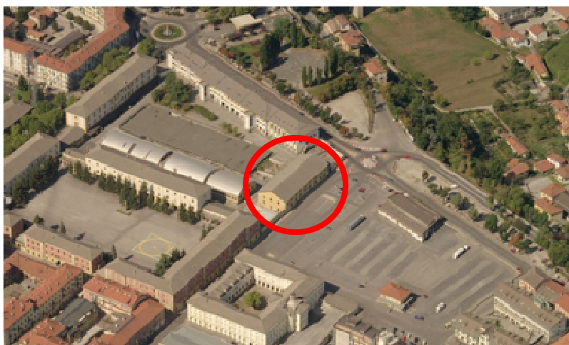
L’area dell’Ex Foro Boario e della Caserma Cantore: il fabbricato dell’Ex Infermeria Cantore
