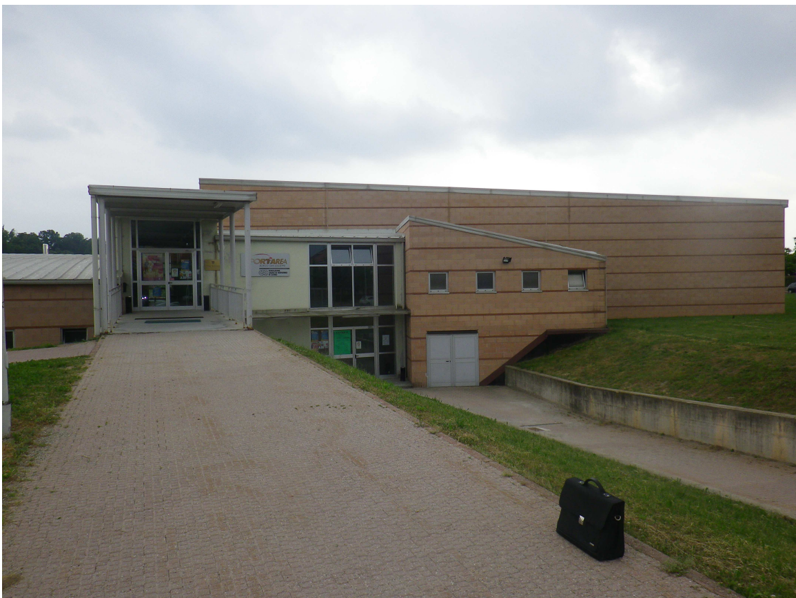
Vista frontale del complesso sportivo; sulla destra il modulo edilizio in oggetto
