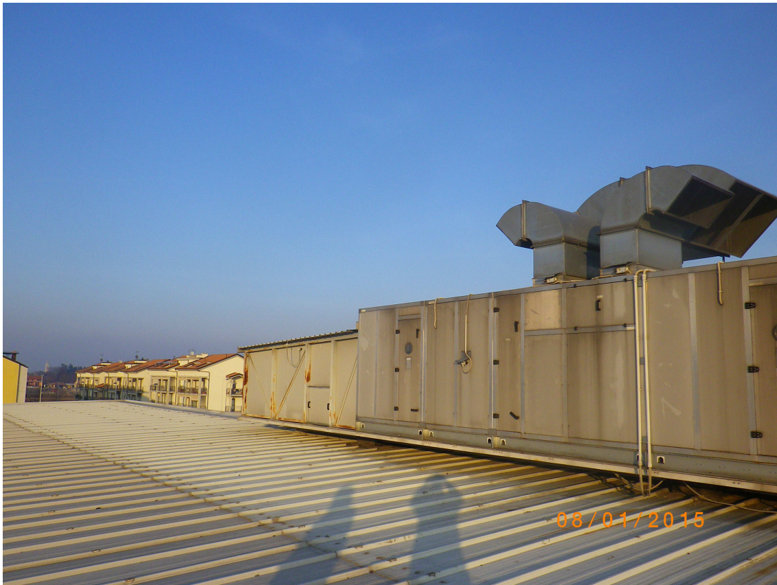
Vista da sopra copertura in oggetto, con U.T.A.
