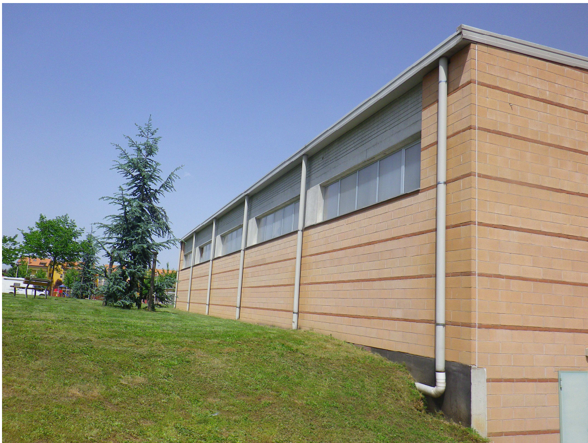
Vista dell'edificio in oggetto sul lato Ovest: visibile qui la gronda presso l'estremità più bassa della copertura
