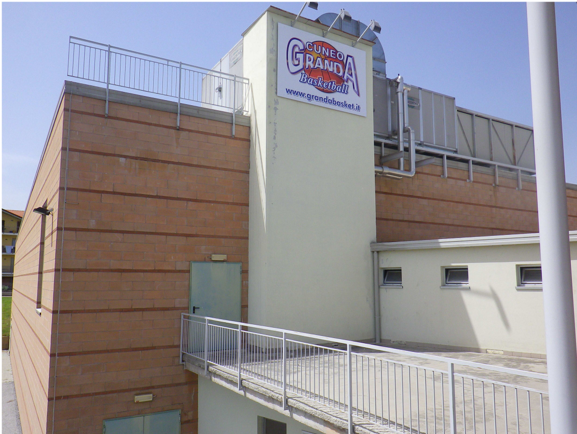
Vista copertura dal retro modulo edilizio , con U.T.A. montata su tetto
