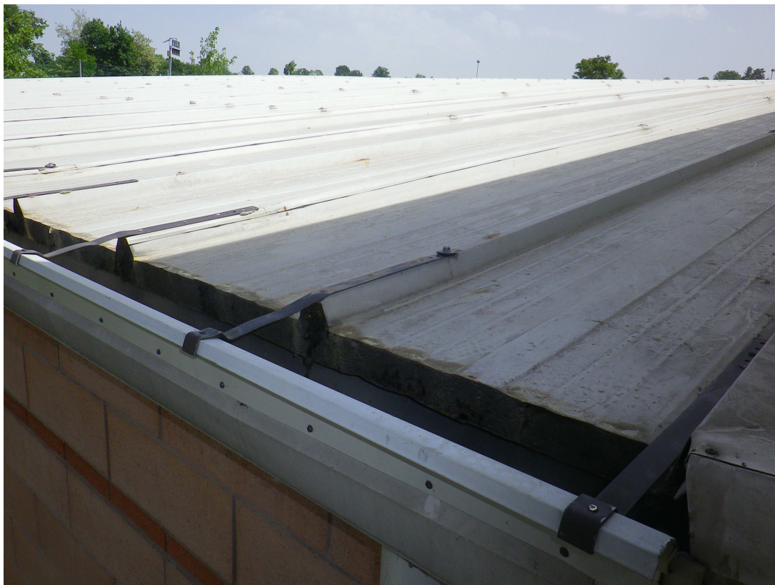
Particolare dell'attuale situazione con i pannelli coibenti sandwich con lamiera
