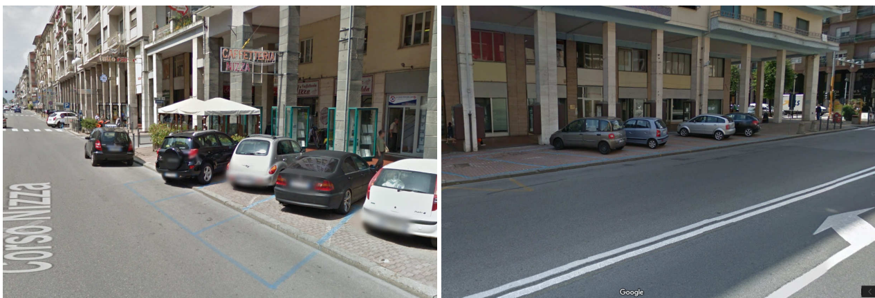
fig. 2 - situazione attuale stalli su corso Nizza – sosta autoveicoli su marciapiede
