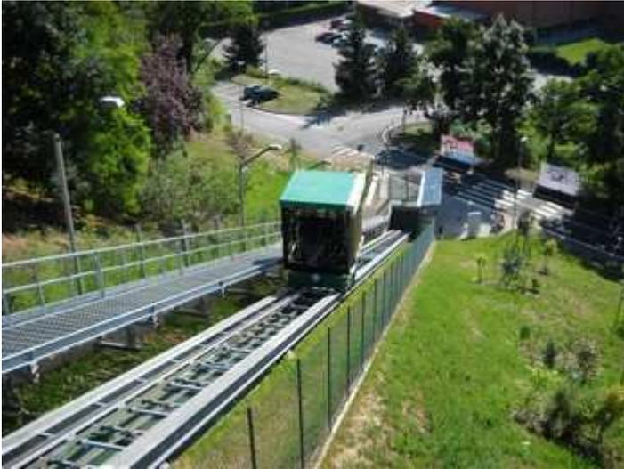
L'ascensore panoramico è costituito principalmente da una vettura a scorrimento su rotaia movimentata da un impianto bilanciato a contrappeso trainato da un argano. Per la prima volta in Europa un impianto di questo tipo è stato dotato di sistemi ad altissimo livello tecnologico.
