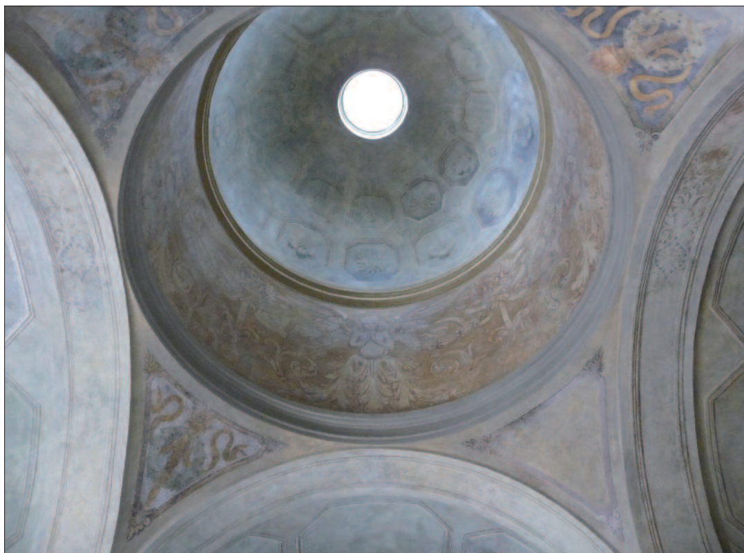
Fig. 6. Cappella, interno, dopo il restauro
