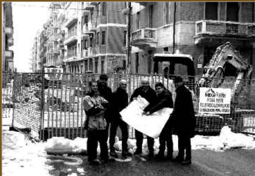
Ripartono i lavori del teleriscaldamento (Foto di Teresa Maineri)
