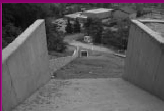
I lavori di costruzione dell’ascensore inclinato
