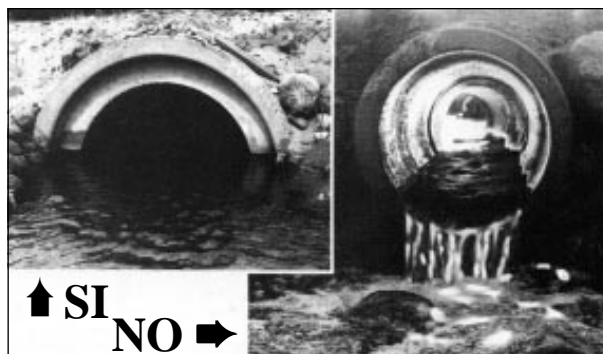
Fig. 51. Esempi di sbocco di un tratto intubato. A sinistra: ecologicamente corretto; a destra: scorretto (ostacola la risalita dei pesci). [da DANISH ENVIR. PROTECTION AGENCY, 1995]
