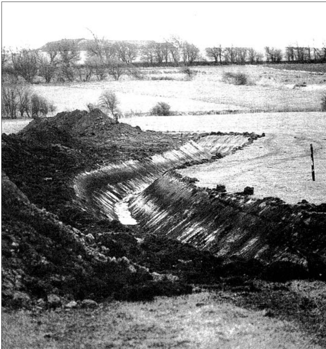
Fig. 55. Scavo di un fosso meandriforme lungo il tracciato del canale Isholm Landgrøft (Danimarca), precedentemente tombato. [da DANISH ENVIR. PROTECTION AGENCY, 1995]
