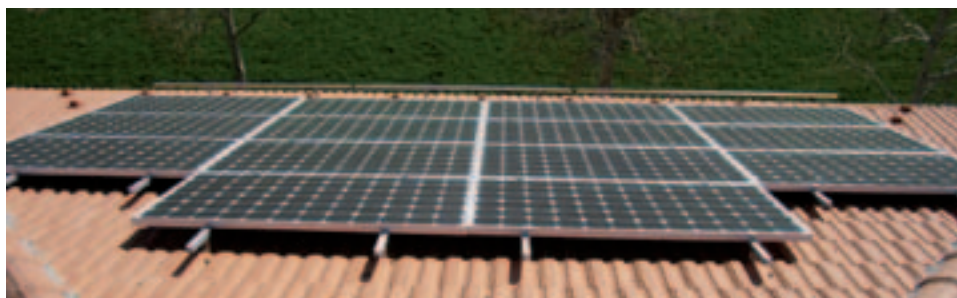
Impianto fotovoltaico scuola Spinetta, Comune di Cuneo
