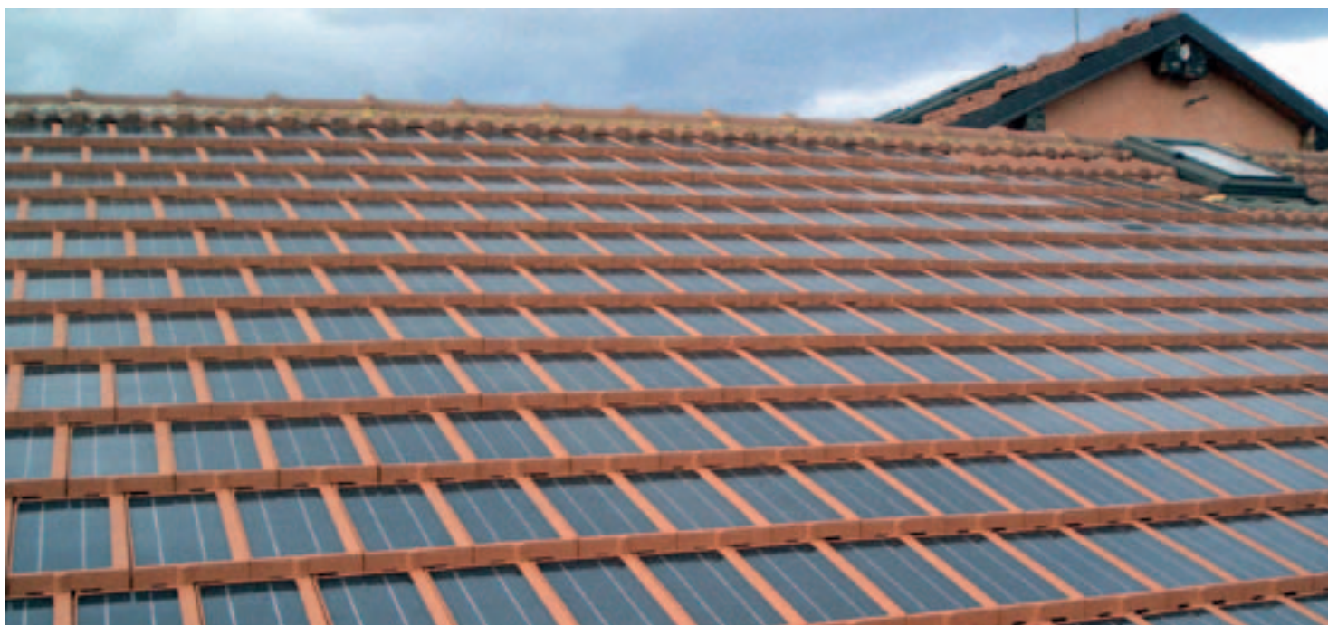
Impianto a tegole fotovoltaiche, centro storico, Comune di Ascoli Piceno
