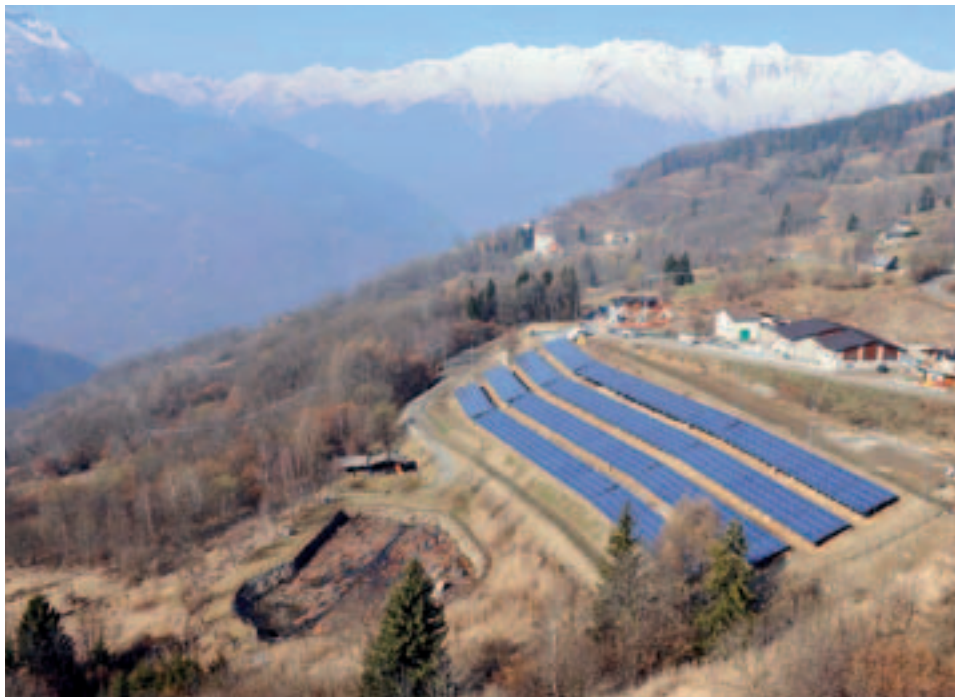
Impianto fotovoltaico in ex discarica, Comune di Cevo (BS)
