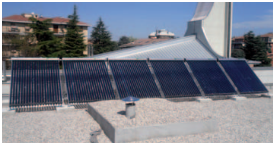
Impianto solare termico asilo Cappuccettorosso, Comune di Parma
