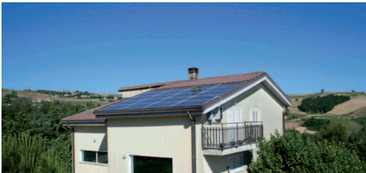
Impianto fotovoltaico realizzato con GAS di Legambiente, Comune di Padova
