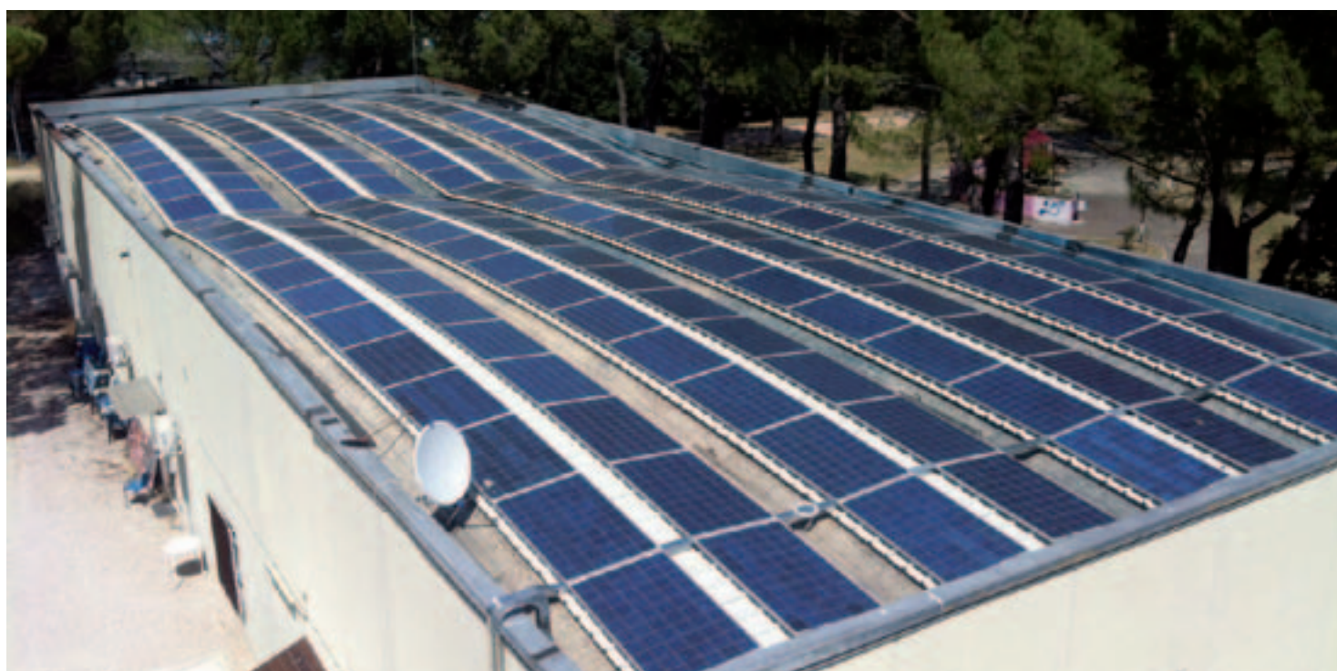
Impianto fotovoltaico ex bocciodromo, Comune di Narni (TR)
