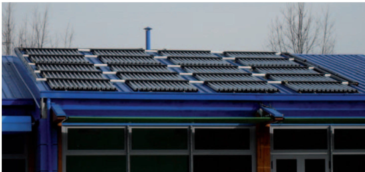
Pannelli solari termici sul tetto dell'asilo, Comune di San Sebastiano Po (TO)
