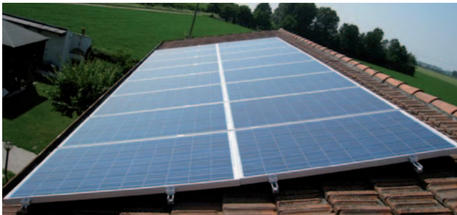
Impianto fotovoltaico su tetto, Comune di Alfonsine (RA)
