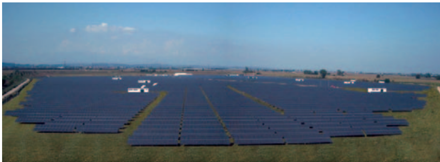
Impianto fotovoltaico in ex cava, Comune di Cigliano (VC)
